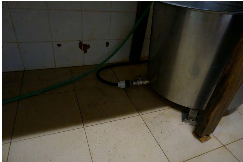
写真 2.3.山小屋から谷の工房に乳を落とす“乳の水道管”(山小屋側)
